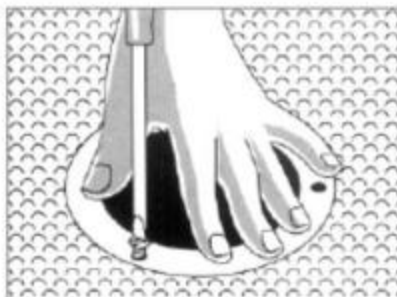
Figure 10 – Raccordement du revêtement au siphon
